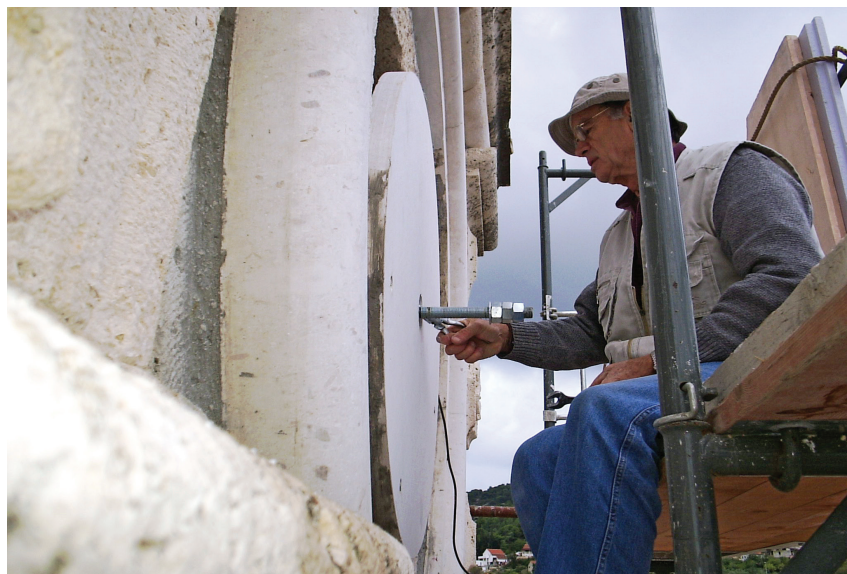
Izrada brojčanika (kamen i emajl) i postavljanje ure na kanpanel u Visu
